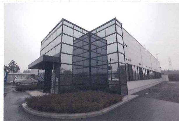
河野製作所つくば工場
